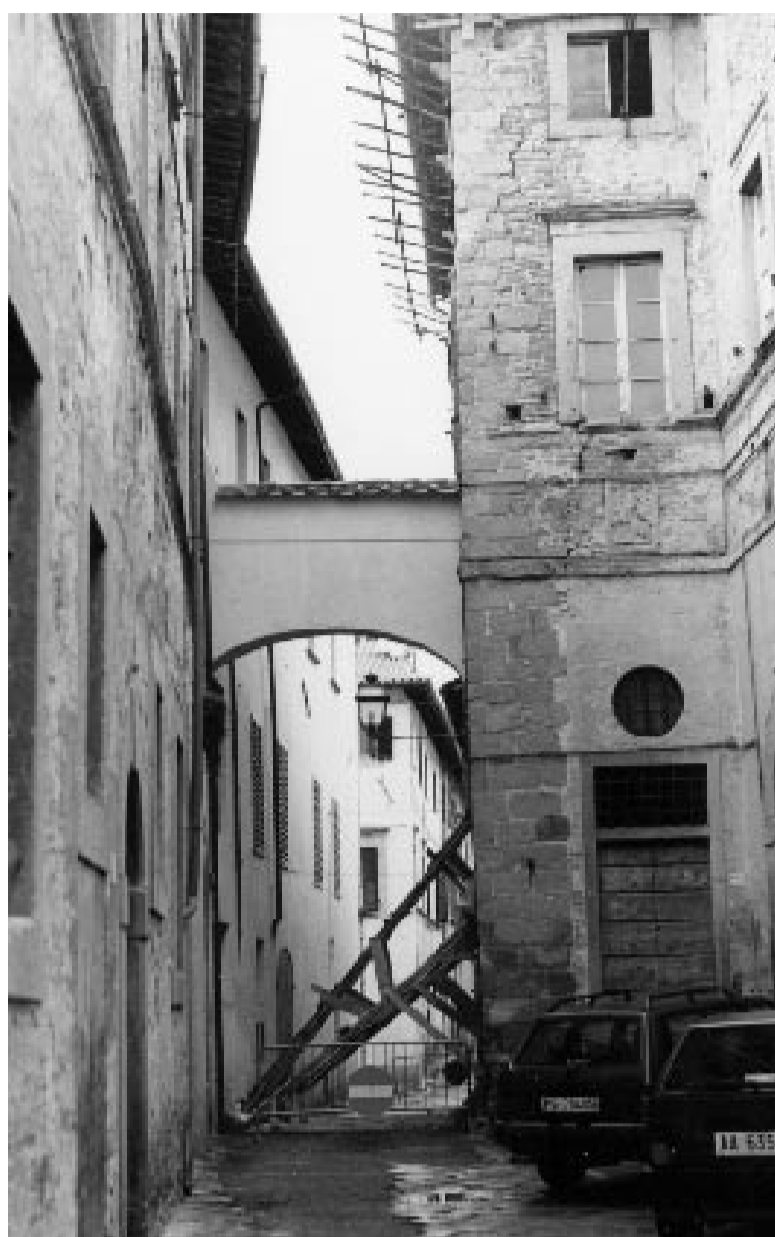
Palazzo Muglioni da via Firenzuola
