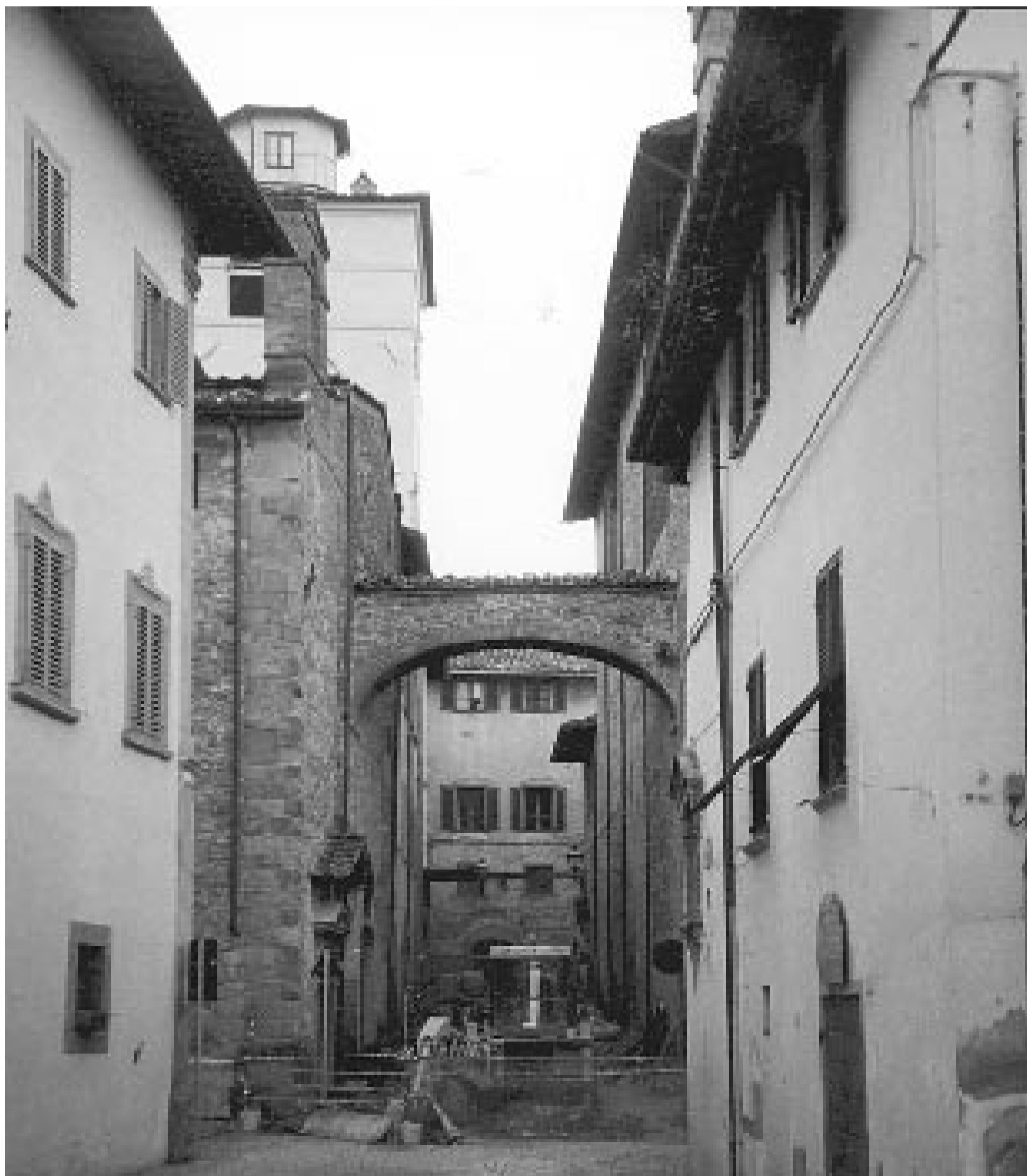
Borgo Sansepolcro - Via Traversari, meglio nota come via Chiusa.
